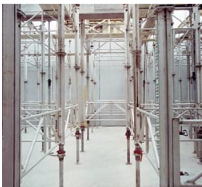
▲ 50 % oszczędności czasu montażu dzięki zastosowaniu rusztowania nośnego MEP w miejsce podpór pojedynczych podczas renowacji starego budynku, Calw/D
