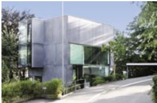
Dom jednorodzinny Gmeiner „Baumhaus“ St. Gallen/CH: fasada elewacyjna z betonem zabarwionym na czarno.
