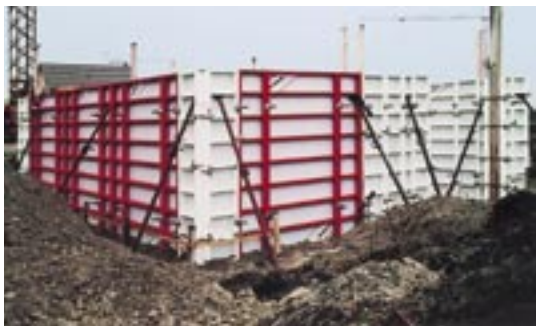
▲ Dla najwyższego bezpieczeństwa: StarTec ze zintegrowanym podestem betoniarskim
