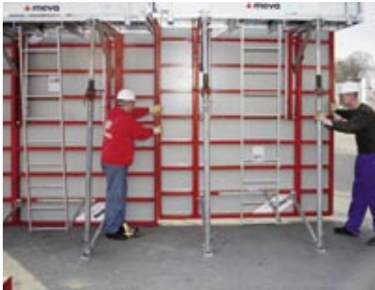
▲ Dla najwyższego bezpieczeństwa: StarTec ze zintegrowanym podestem betoniarskim
