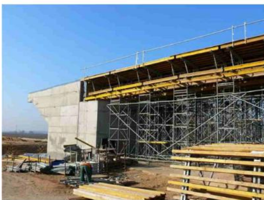
Autostrada A1, Wiadukt Kolejowy WA-190
