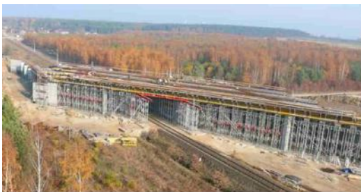
Autostrada A1, Wiadukt Kolejowy WA-198
